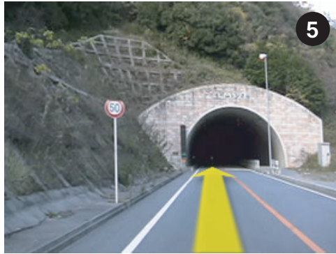
5 遙照山頂上付近にトンネルあり
